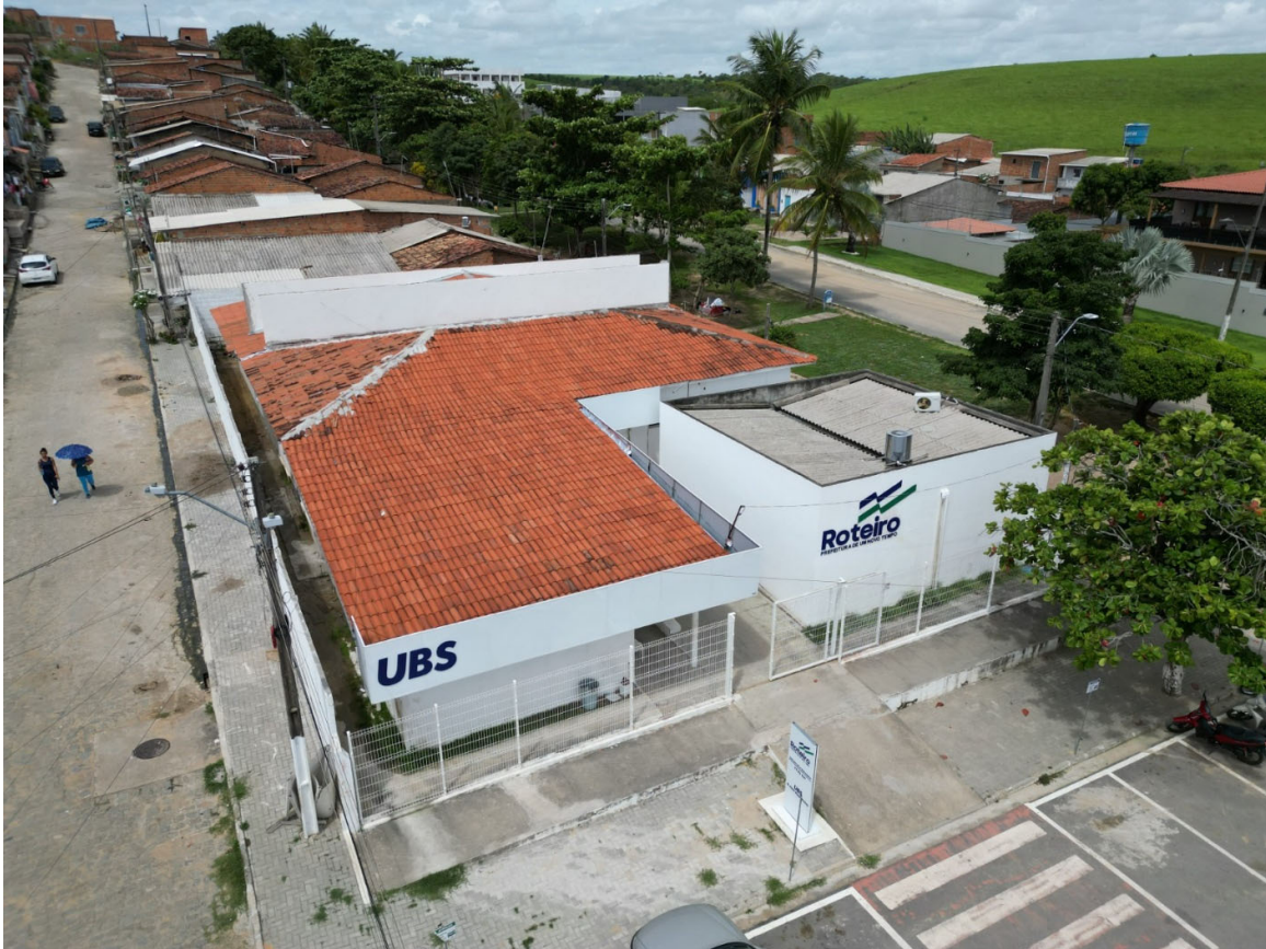
7CENTRO DE SAÚDE DE ROTEIRO ELÁDIO MARCELINO DEPOIS DA REFORMA
