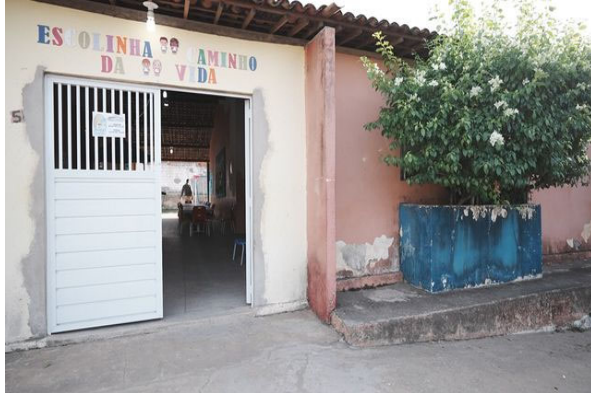
1 ESCOLA CAMINHO DA VIDA ANTES DA REFORMA
